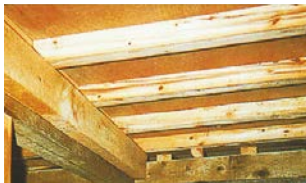
B 床下換気扇を設置している床下
